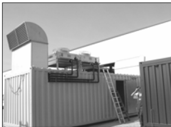
Joonis 5-8: Eraldiseisvasse hoonesse paigutatud konteinertüüpi SEK; fotod: Seva Energie AG.
