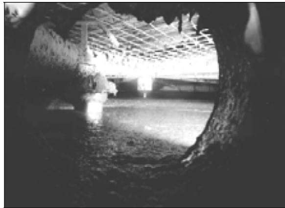
Joonis 3-30: Käärituskambri sisevaade; foto Biogas Nord GmbH.
