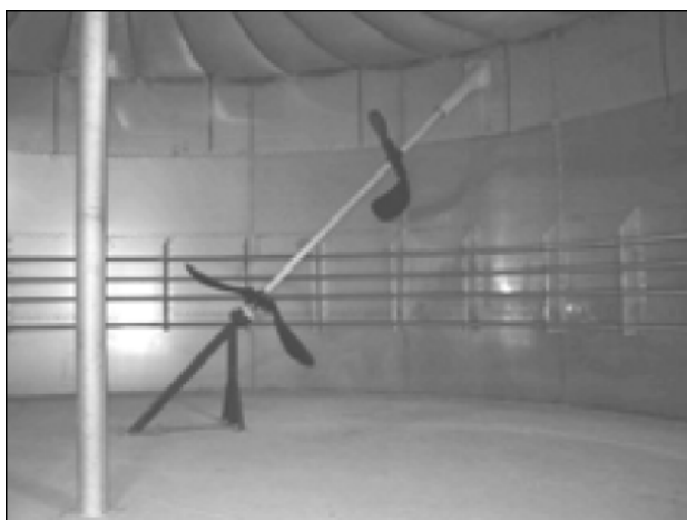
Joonis 3-37: Pikateljeline segisti koos ja ilma põrandale kinnitusega; foto; WELtec BioPower GmbH; graafika: Armatec FTS-Armaturen GmbH.
