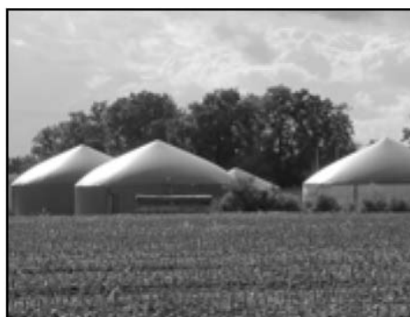
Joonis 3-42: Gaasihoidla alumised konstruktsioonid (vasakul), kilekaanega käärituskambrid (paremal). Fotod: MT-Energie GmbH.
