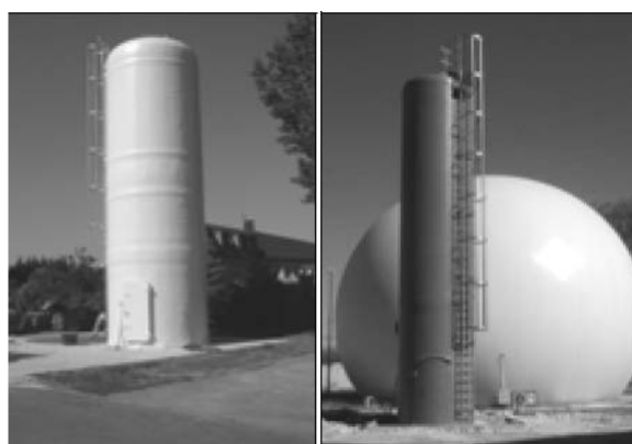
Joonis 5-2: Välised bioloogilised väävlialduskolonid, paremal koos gaasihoidlaga; fotod: S ja H GmbH ja CO Umweltengineering KG.
