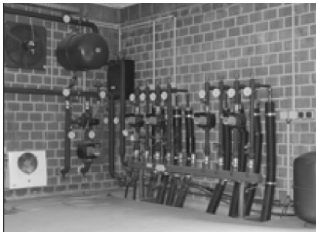
Joonis 5-6: Soojuse jaotussõlm; foto MT-Energie-GmbH
