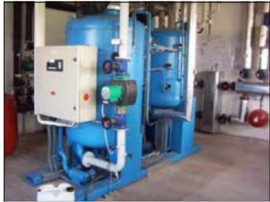
Joonis 5-15: Absorptsioonkylmutusseade ühes biogaasijaamas.
