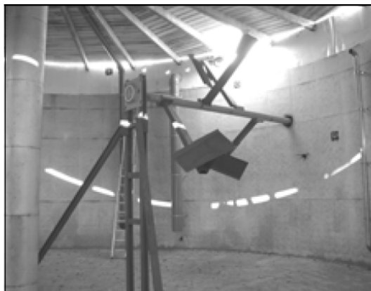
Joonis 3-39: Mõlasegisti (paremal); foto: PlanET Energietechnik.
